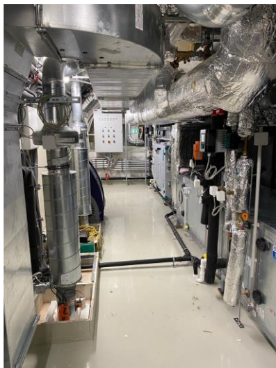
Verkabelung der HKLS Zentrale
